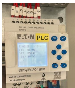
Figura 17: Foto del temporizador que permite controlar los ciclos de encendido(on) y apagado (off) de cada bomba. Fuente: Milagros Peña (2023).
